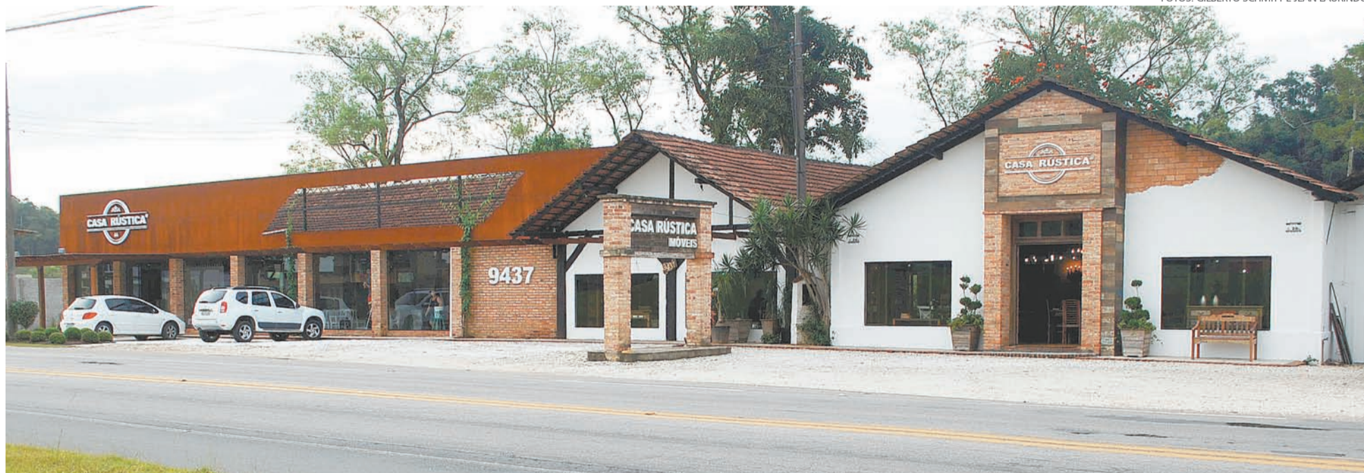
CASA Rústica Móveis fabrica e vende móveis de madeira há 31 anos em ponto comercial na rodovia Jorge Lacerda, bairro Pocinho
