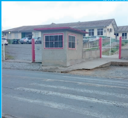
BELA Vista deve receber repinturas em breve
