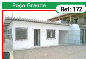
Poço Grande Ref: 172 Casa. 2 quartos, cozinha, banheiro, sala, garagem. Util: 90,00m 2 . Valor: R$ 950,00.
