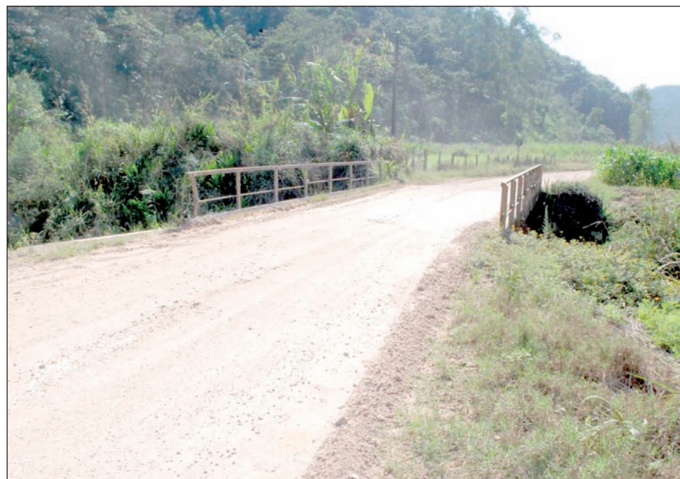
BAIRROS apresentam pontes "mistas, de madeira e de concreto ao mesmo tempo
