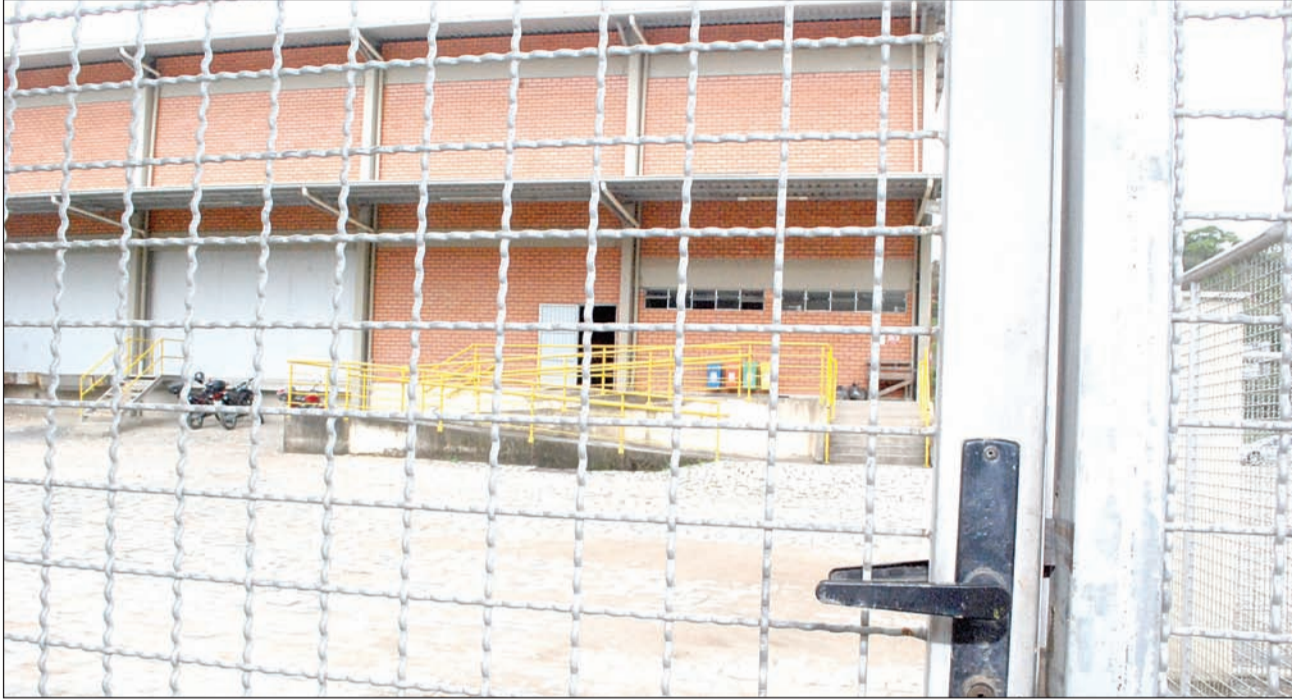
DESMONTAGEM da estrutura interna está sendo feita até esta sexta-feira, dia 18
