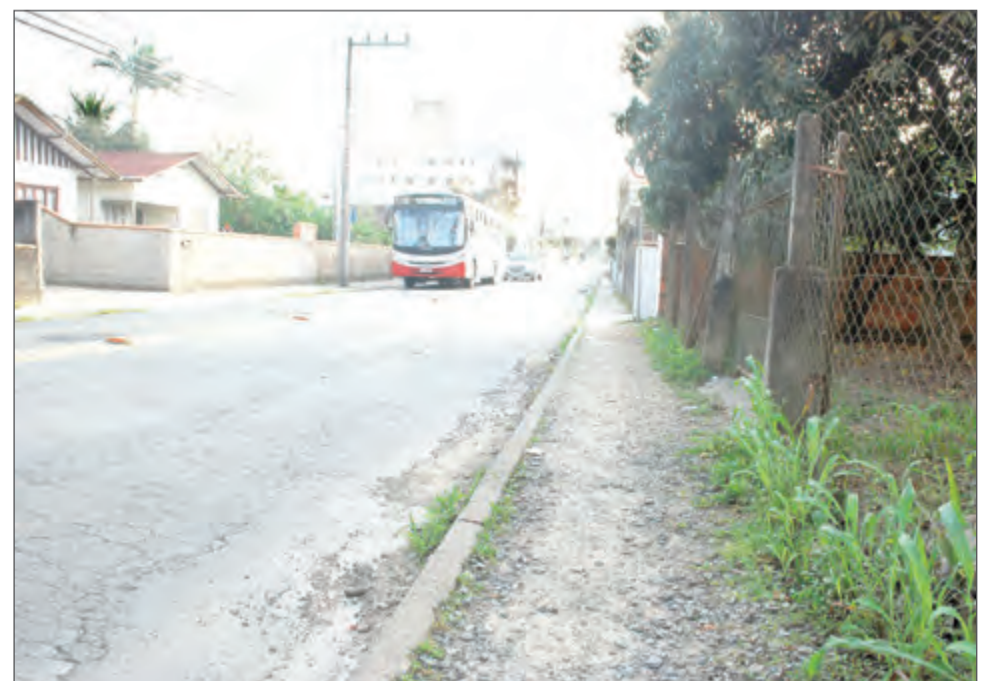
Falta de manutenção é ponto recorrentes nas reclamações de pedestres
