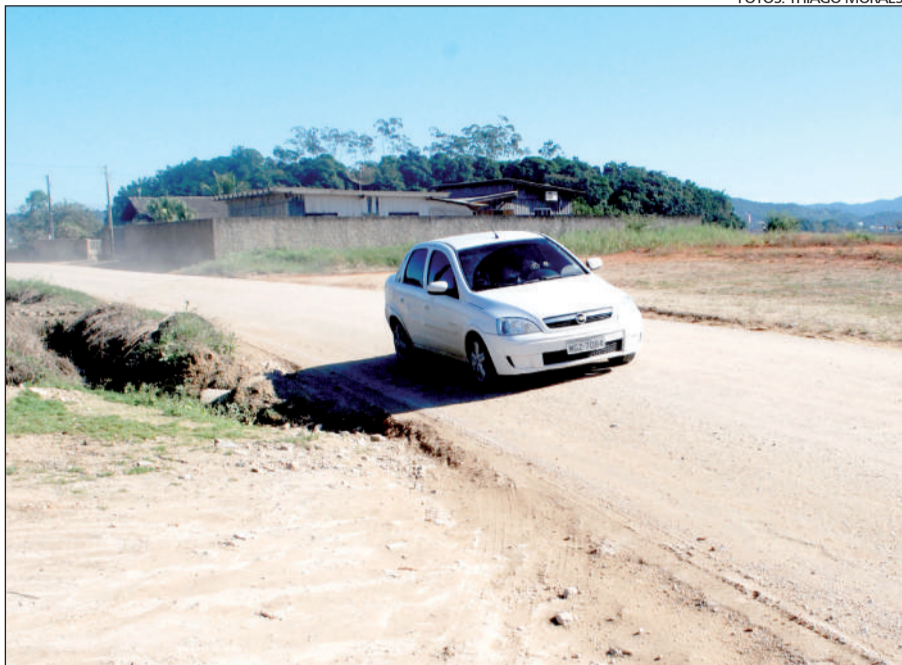
Junto com a pavimentação e a drenagem, a obra terá ciclovia e calçamento
