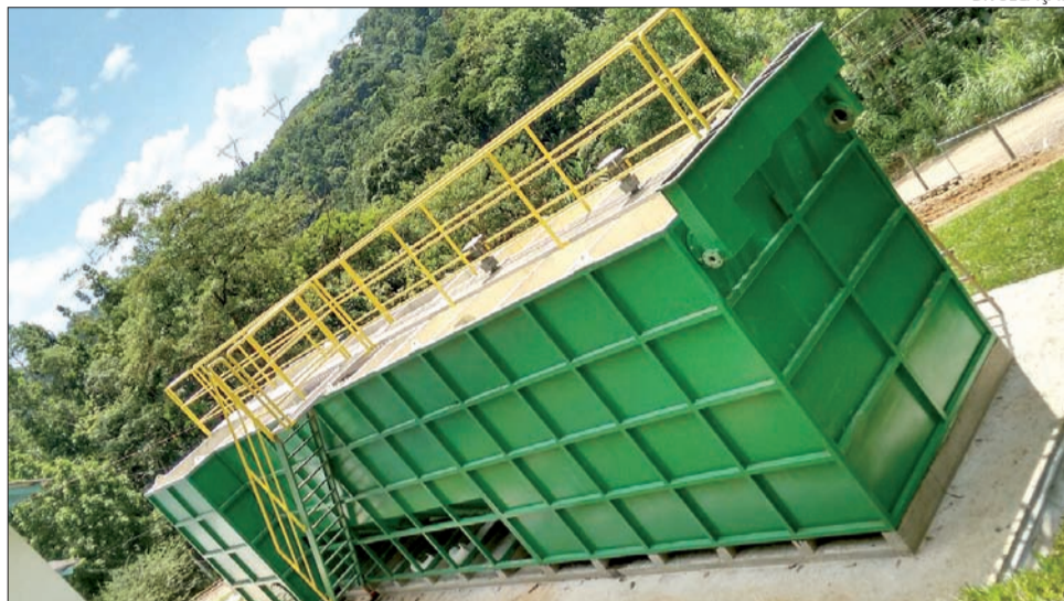
ESTAÇÃO compacta promete elevar volume de água tratada de 14 para 20 litros por segundo
