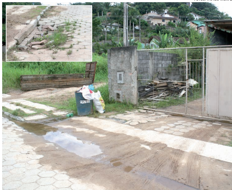
RUA vem sofrendo com cheias; lajotas soltas (detalhe) também são problemas relatados
