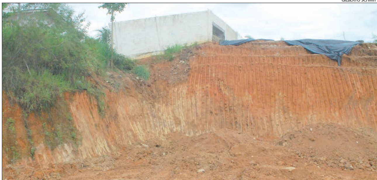
ESCAVAÇÃO foi feita durante o feriado de Carnaval e foi notificada pela Defesa Civil, que deve providenciar vistoria
