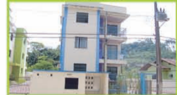
(OP 237) - Apto de nº 301 do Residencial Safira contendo sala de estar/jantar, 2 dormitórios, sendo 1 suite, bwc, cozinha, a.s., sacada com churrasqueira, 1 vaga de garagem. R$ 160.000,00.
