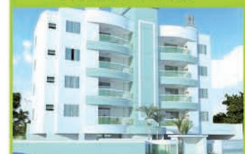
(F-01) Residencial Portinari, constituído de 5 pavimentos, sendo o térreo garagens e mais 4 pavimentos de apartamentos, com 2 apartamentos por andar, prédio com elevador, acesso automatizado. O apto constituído de sala de estar/jantar, 1 suite + 1 dormitório, cozinha, área de serviço, sacada c/ churrasqueira, 1 ou 2 vagas de garagem. Incorporação R-2-23.731. R$ 253.000,00.
