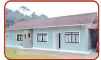
Ref: 713 Casa com 2 quartos, suíte, sala, cozinha, banheiro e 2 vagas de garagem. Sete de Setembro | R$ 425 mil
