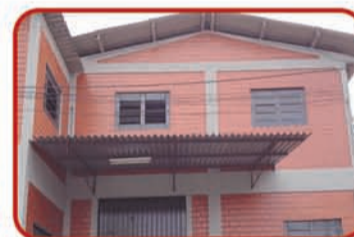
REF. 745- (LOCAÇÃO)2 Banheiros, Escritório e Elevador de Carga. Metragem: 522m². RS 4.800,00.
