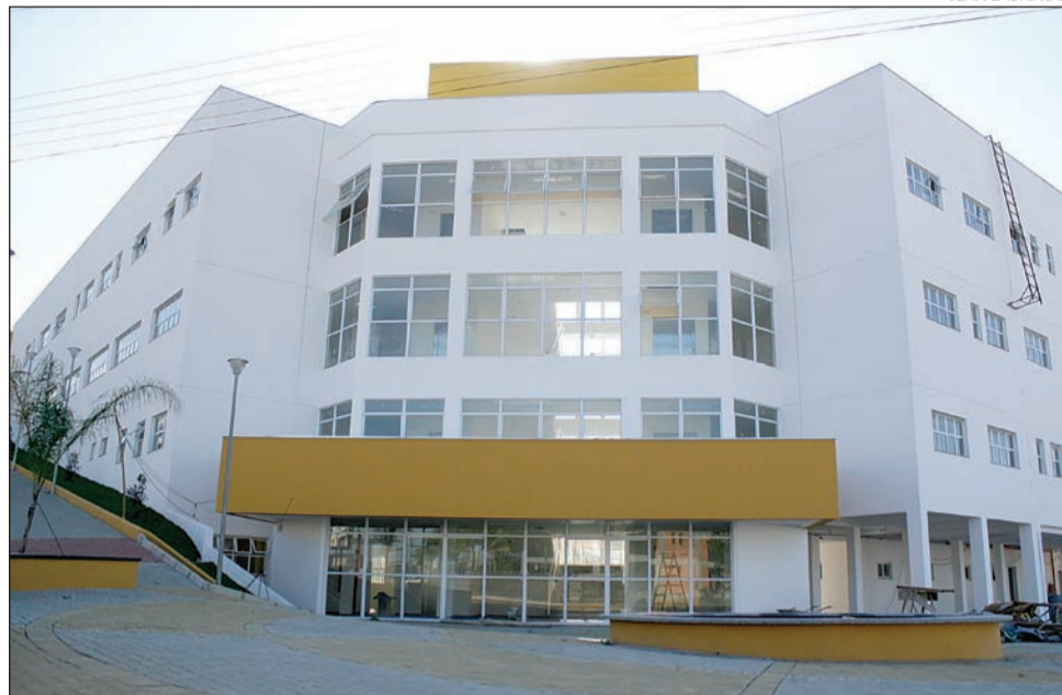
OBRA atualmente se concentra em estágios como parte elétrica e acabamentos
