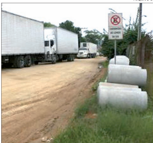
RUA Francisco Spengler recebeu tubos antes da pavimentação
