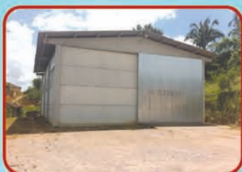
REF. 708 - Galpão com 1 BWC. 18 X 12. Rede elétrica trifásica em andamento; Pé direito 5 metros - Porta Industrial. 216m². Santa Terezinha. R$ 1.950,00
