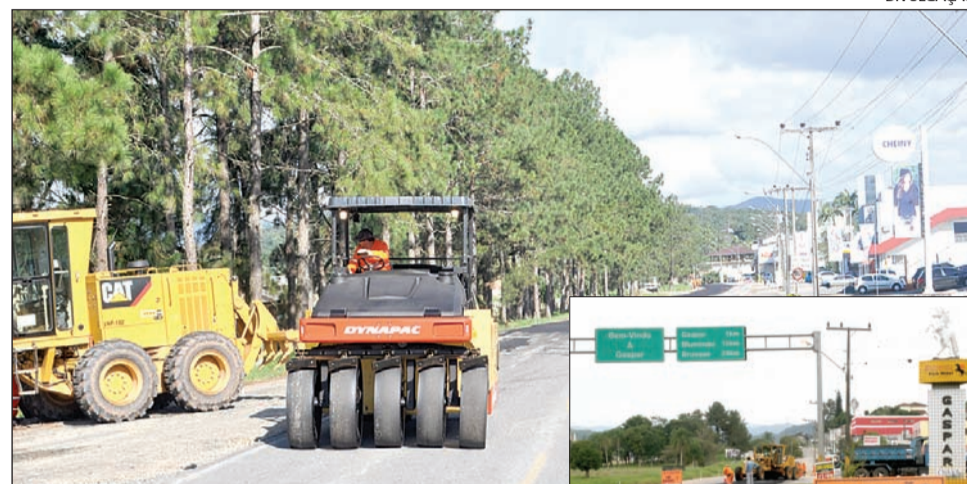
OBRAS iniciaram-se na última sexta-feira, 20 de junho
