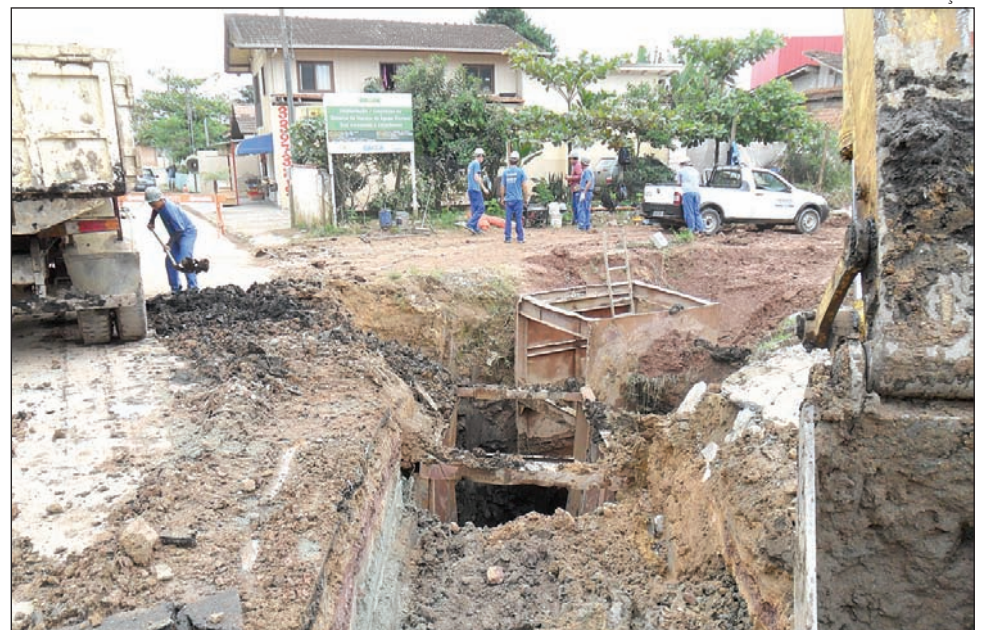
DRENAGEM da rua Amazonas começou em dezembro de 2013 e deveria estar concluída em 90 dias
