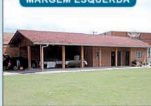
Ref: 347: Terreno pronto para construir. Plano. Livre de enchen-tes. Possui uma edificação de alvenaria com aproximadamente 90,00 m 2 - novo - utilizado para cozinha e refeitório de funcionários de uma empresa de confecção.
