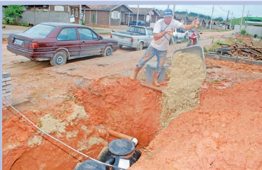
A fossa e o filtro foram instalados neste sábado.
