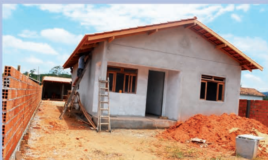
Casa começa a receber pintura e os tijolos do muro já foram assentados.
