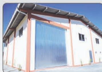
Galpão de alvenaria 300m da BR 470/ 750m 2 Belchior Baixo - Ref. 609
