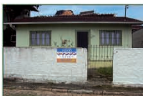
SANTA TEREZINHA Cod. 129: Casa, sala, cozinha, WC, 3 quartos, lavação. R$ 680,00.
