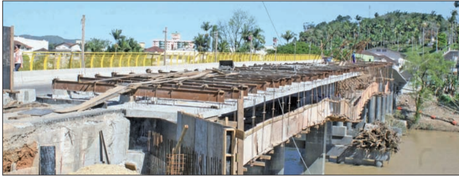
OBRA de recuperação da ponte caminha para as últimas etapas
