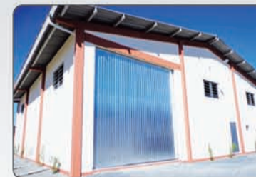
Galpão de alvenaria 300m da BR 470c/ 750m 2 Belchior Baixo - Ref. 609
