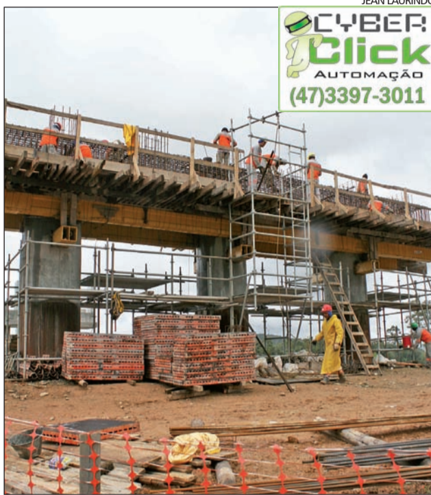
LANÇAMENTO de vigas próximo à BR-470 dá continuidade aos trabalhos
