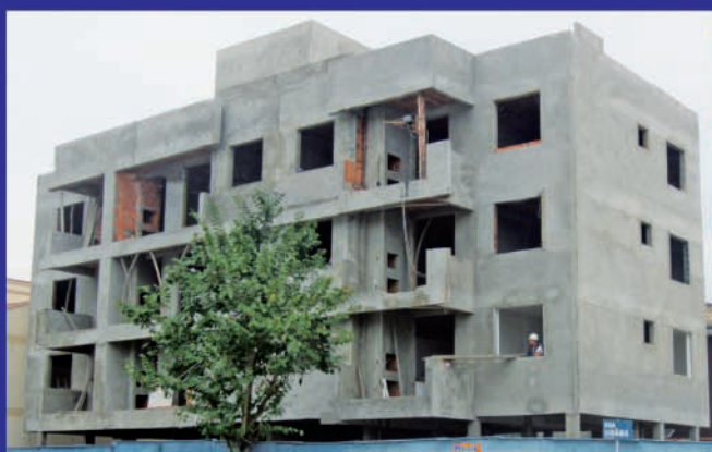
ESTÁGIO ATUAL DA OBRA
