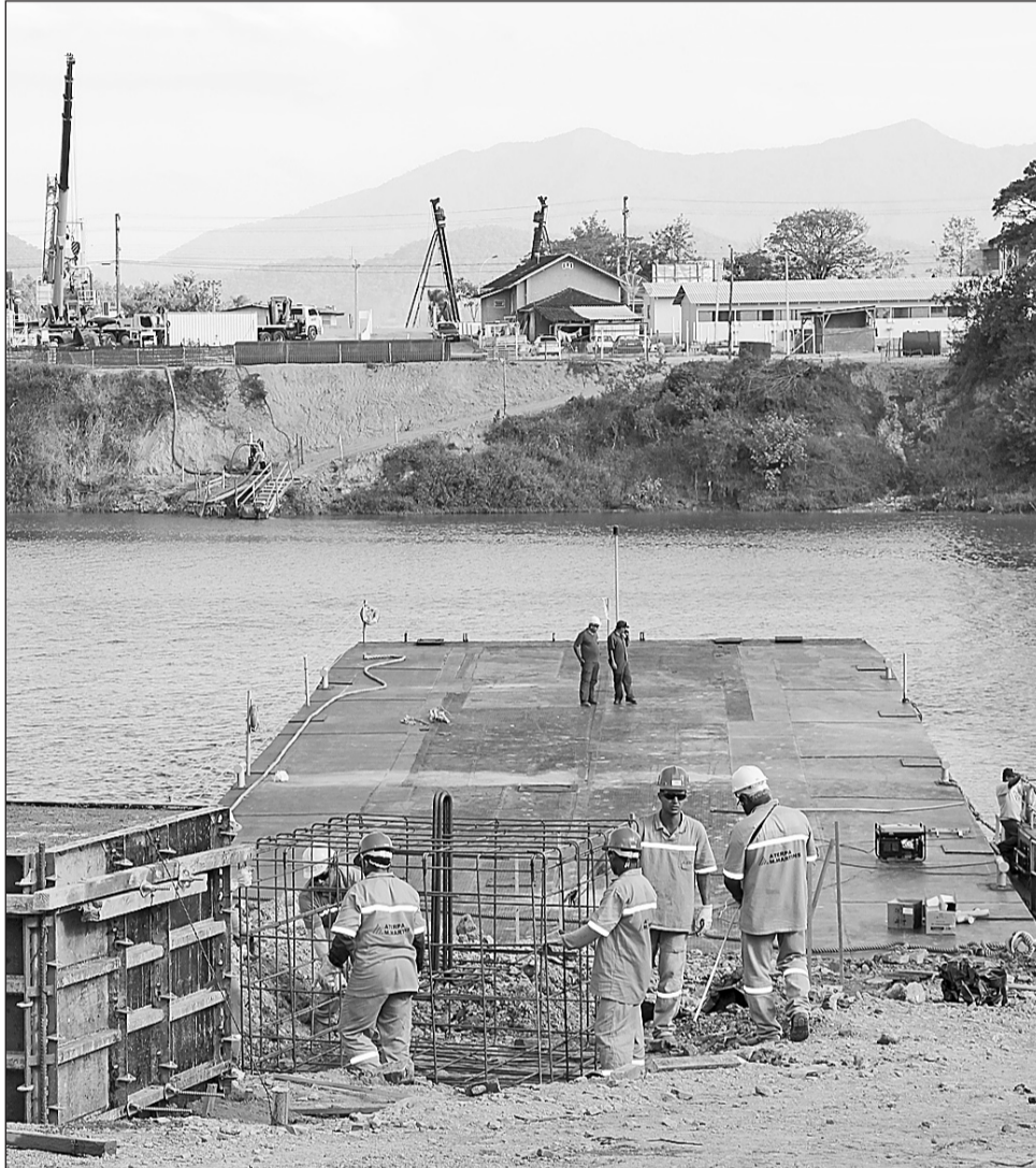
FUNCIÓNÁRIOS da empreiteira trabalham em ritmo acelerado desde o início das obras
