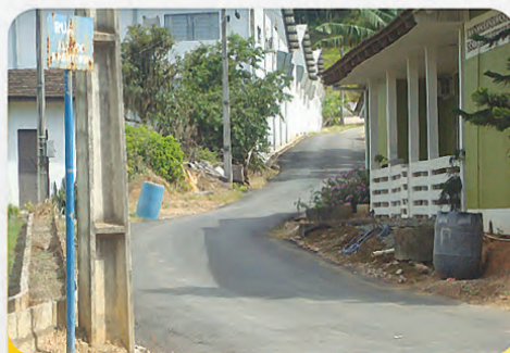
Pavimentação da Rua Alfredo Siementekovisk - Belchior Central
