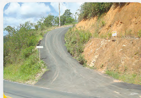
Pavimentação do acesso da Rua Alberto José da Silva
