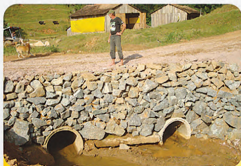
Tubulações na Rua Emilio Roweder Belchior Alto
