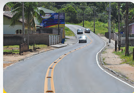
Pavimentação da Rua Heldo Florentino Wan-Dall
