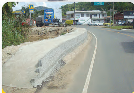
Muro de Contenção Rua Bonifácio Haendchen - Belchior Central
