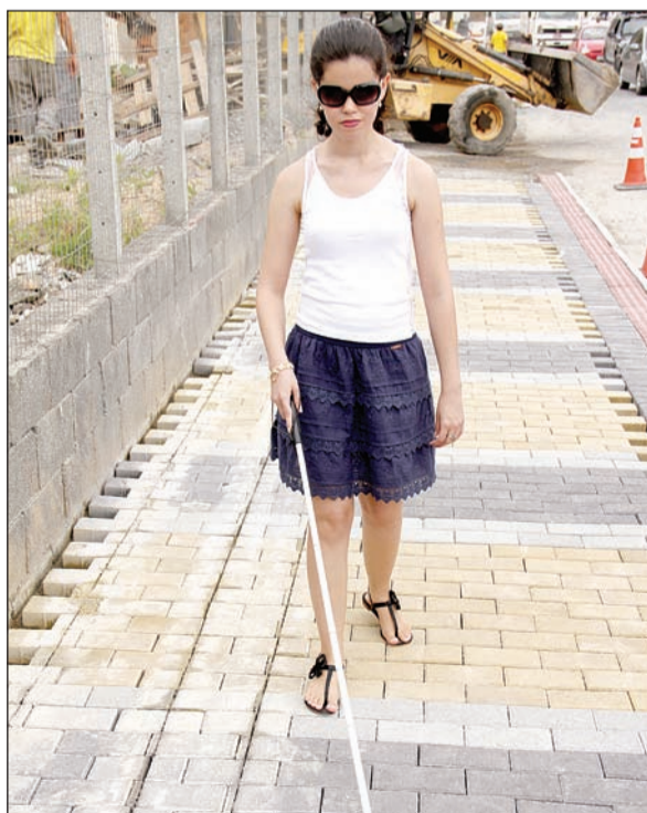
PISO tátil está correto, mas alerta junto ao meio fio estaria errado
