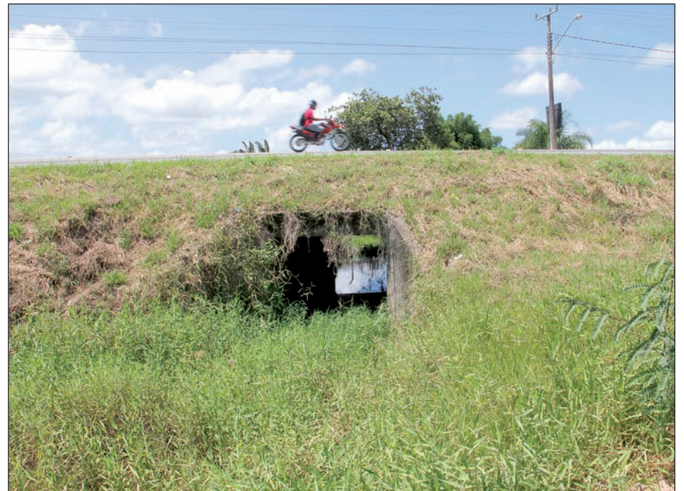
TÚNEL que deveria ser utilizado para travessia de pedestres está coberto de mato e acumula água
