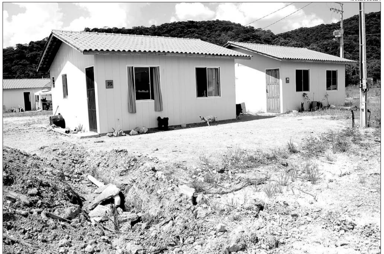
CHAVES das casas foram entregues no final de 2011, mas loteamento ainda precisa de infraestrutura, como rede de esgoto
