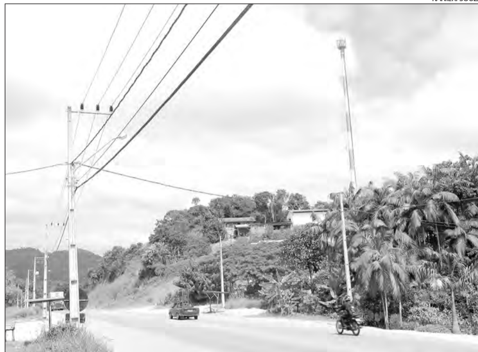
ANTENA da operadora TIM está instalada bem próximo à rodovia Ivo Silveira, no bairro Barracão
