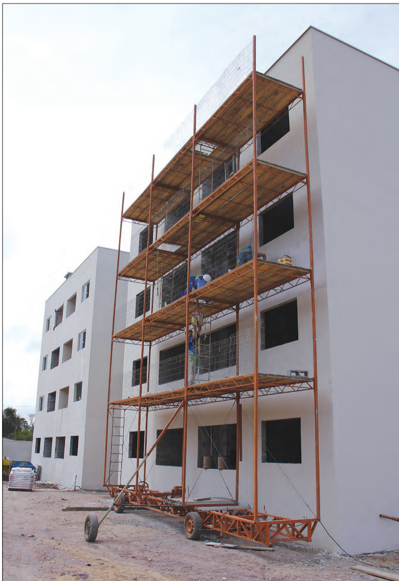
Blocos que já estão prontos, recebem pintura e últimos acabamentos
