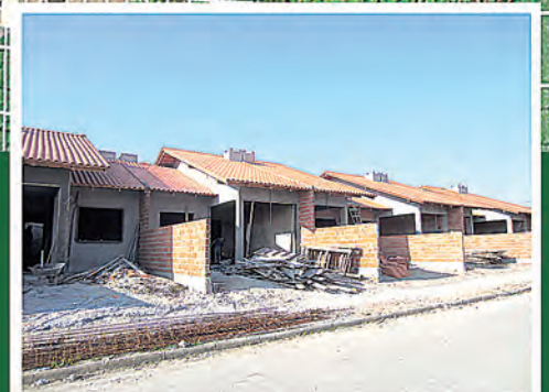
Andamento da obra
