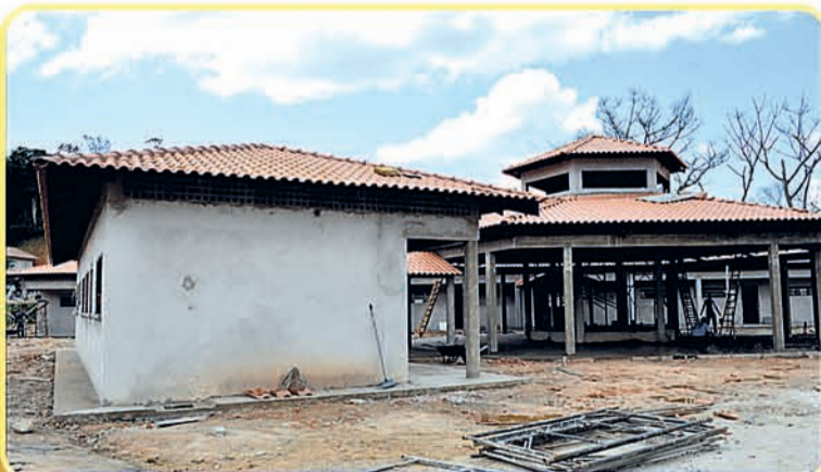
3 Construção da Escola Luiz Franzói - Bairro Bateias
