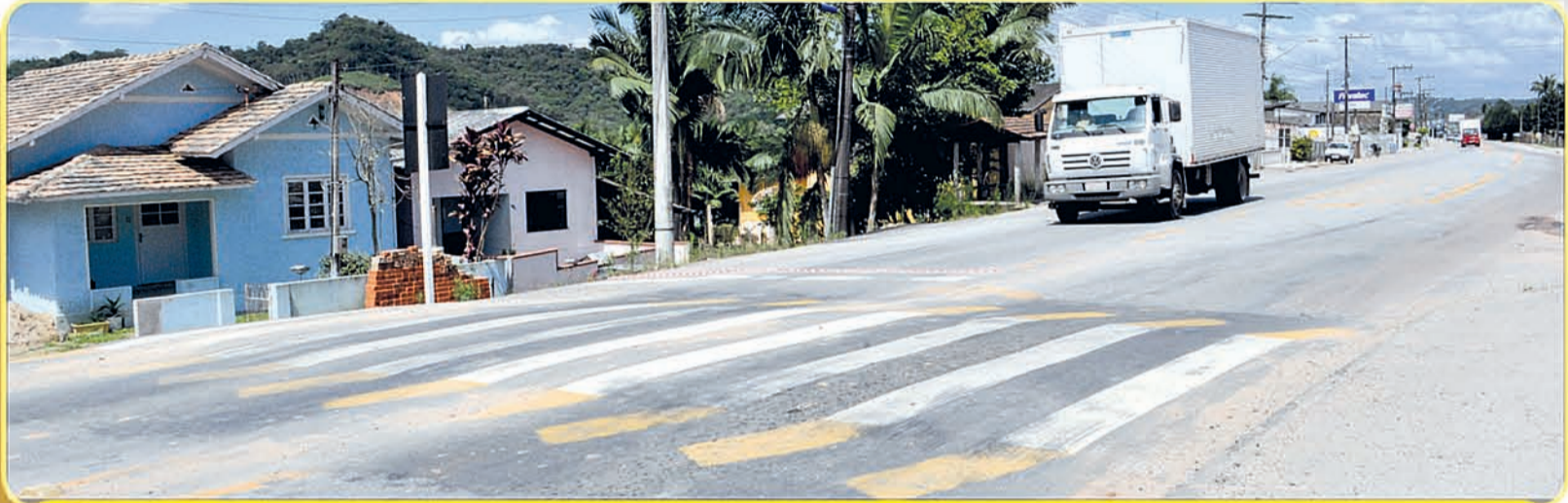
1 Implantação de Travessia Elevada para Pedestres no Bairro Figueiras
