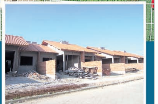
Andamento da obra
