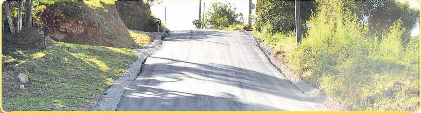
1 Pavimentação da Rua São João - Bairro Centro
