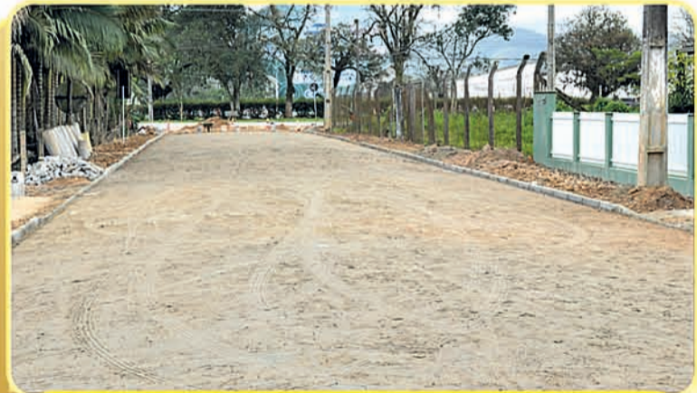
4 Pavimentação da Rua Renato Manoel Peixoto Bairro Poço Grande
