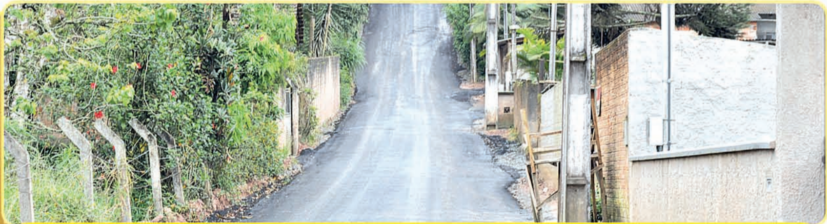
2 Pavimentação da Rua Silva - Bairro Bateias
