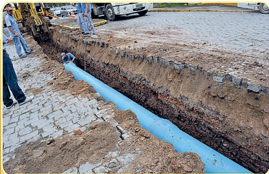
3 Substituição da rede macro de distribuição de água potável.
