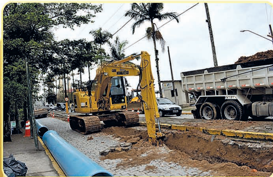
4 Substituição de tubos de 250mm para 500mm de diâmetro, aumentando em 4 vezes o volume da distribuição de água.
