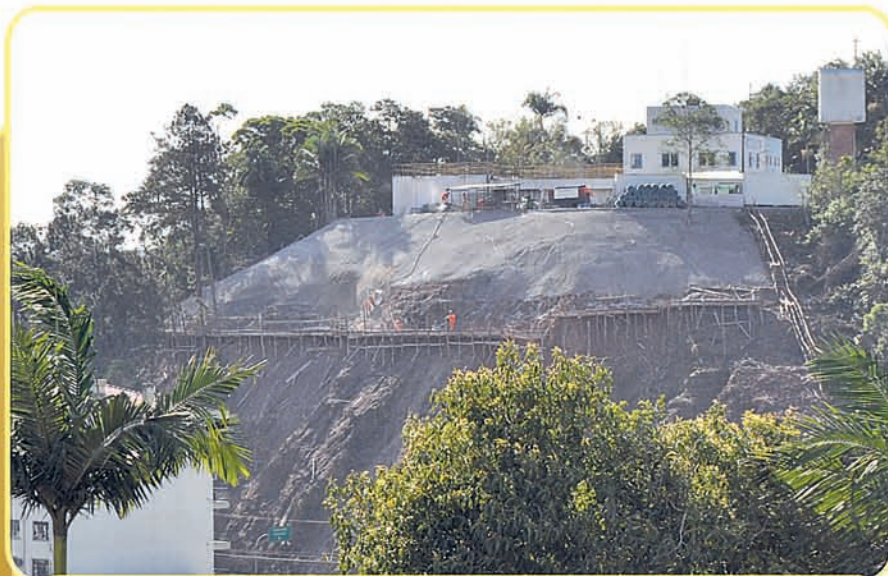
2 Para evitar novos deslizamentos, além de um muro de contenção, serão colocados grandes grampos no solo para depois concretar a parte afetada.
