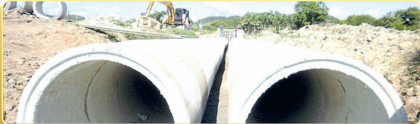
1 A nova tubulação do Bairro Santa Terezinha recebeu investimentos no valor de R$ 5,1 milhões, melhorando a drenagem pluvial.
