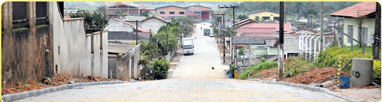
2 Com esta melhoria, algumas ruas estão sendo pavimentadas, como a Rua Pedro da Rocha.
