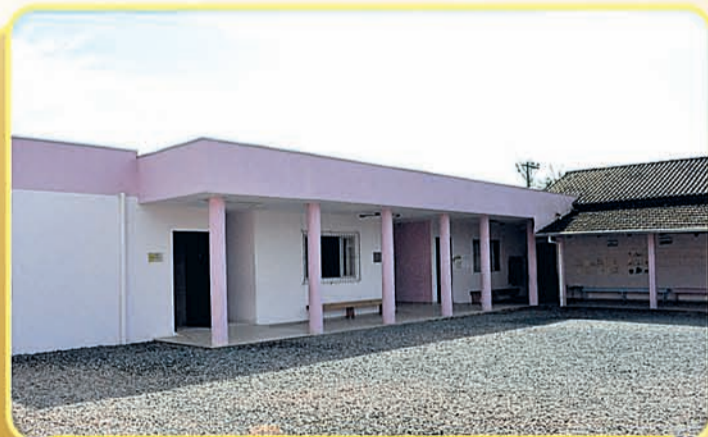
6 Reforma e ampliação da Escola Belchior Central Bairro Belchior.
