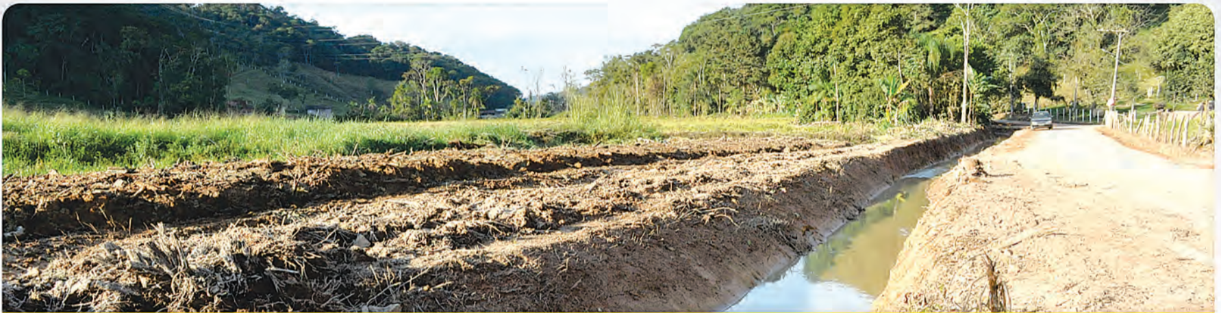
1 Desassoreamento do Ribeirão Garuba
