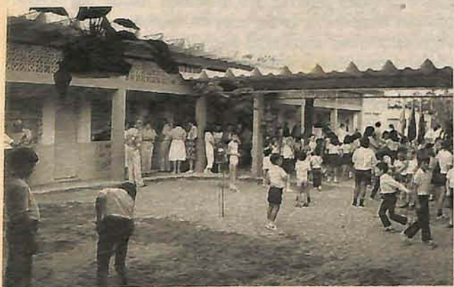
EM 1991, começou a ser erguida a nova estrutura da escola
