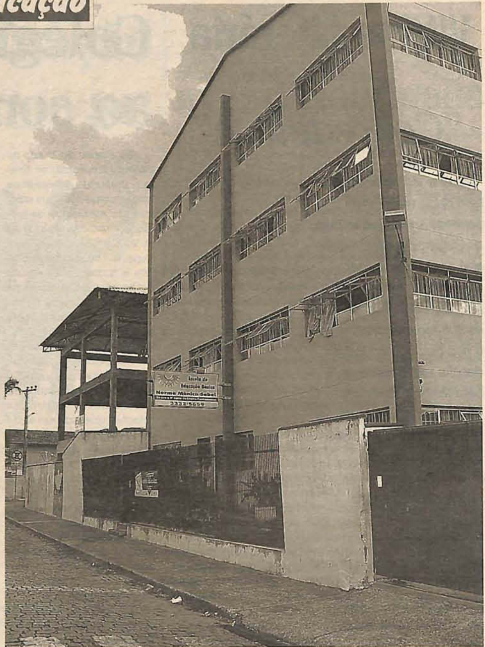
SALAS DE AULA funcionam no prédio de três andares, e já está pequena para os alunos
