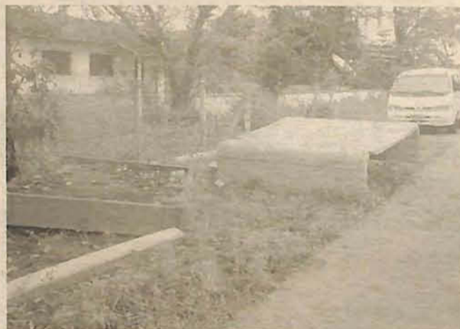
Comunidade fica sem local adequado para aguardar o ônibus
