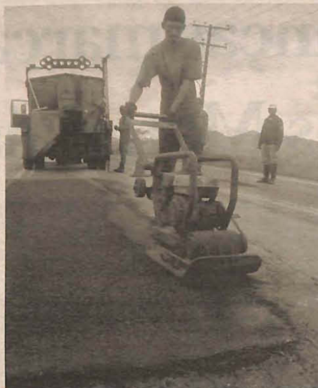
Operação de emergência age sobre os locais de maior risco
