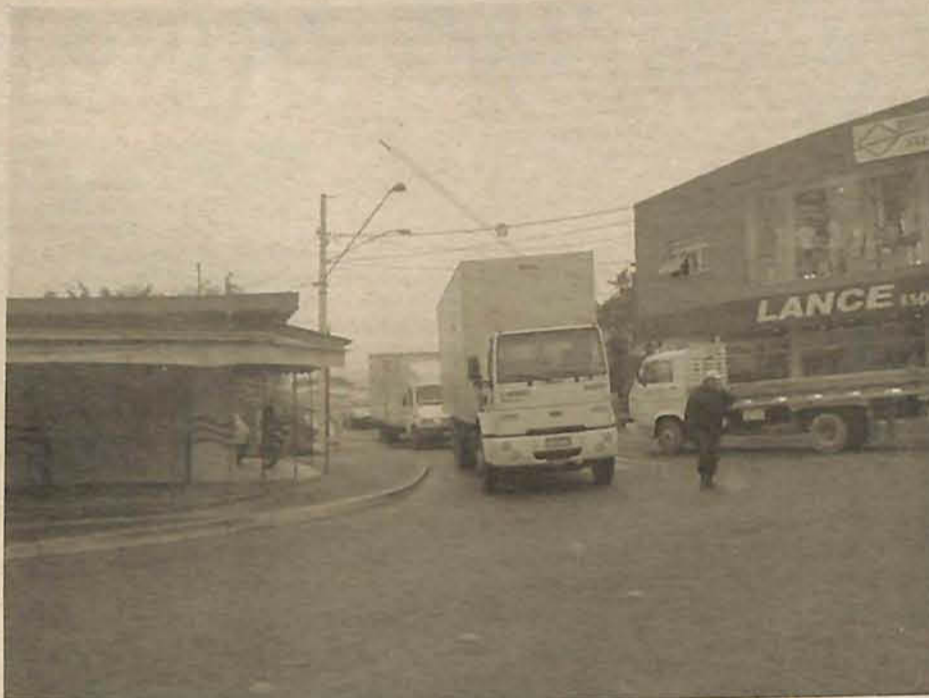
Motoristas continuam trafegando com caminhões acima do peso permitido sobre a ponte
