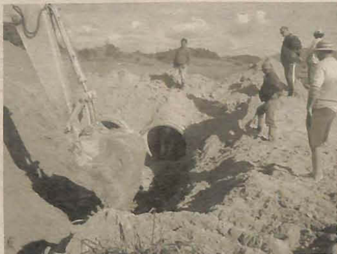
Tubulação de concreto substitui antiga ponte de madeira
