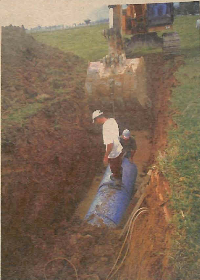
Custo total da obra de canalização vai ficar em torno de R$ 15 mil
