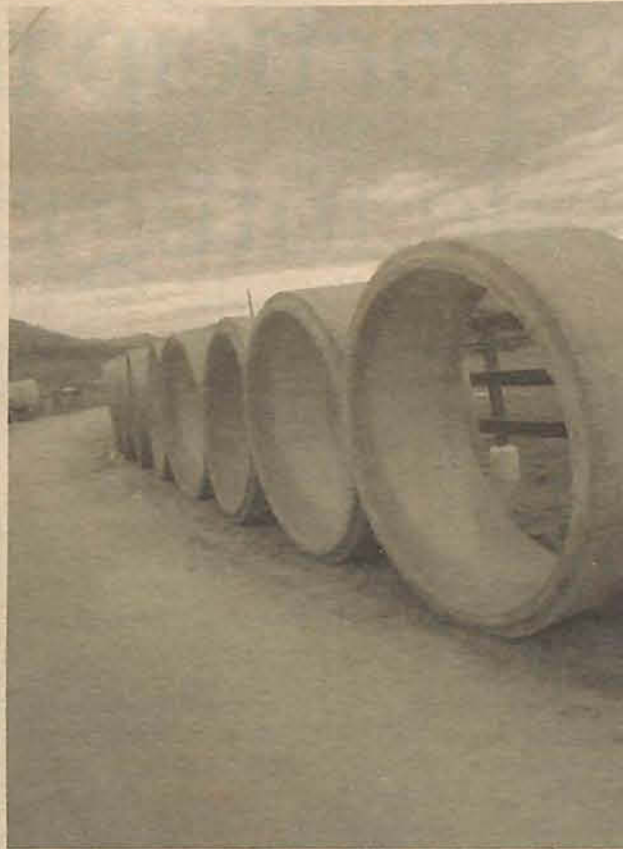
Tubulação já está aguardando obras de saneamento
