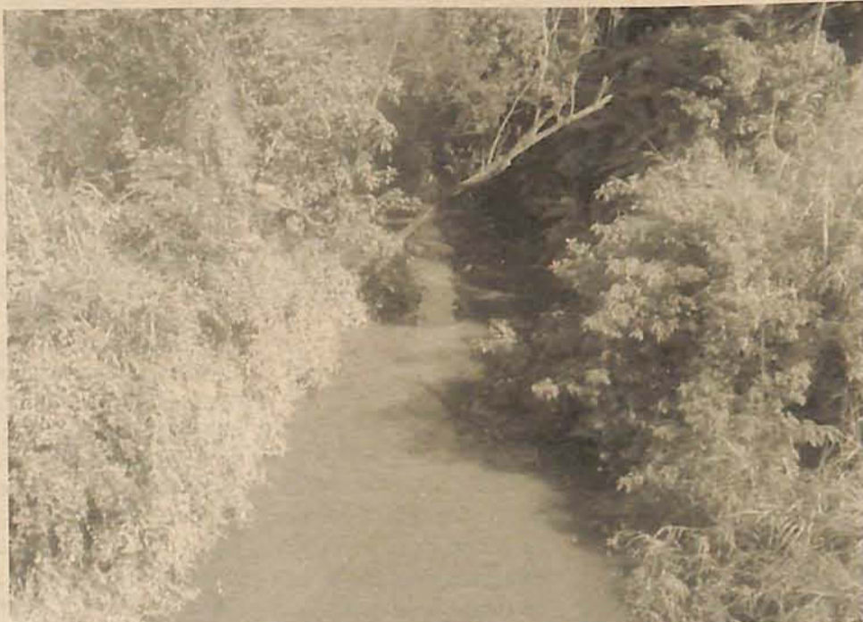
Desassoreamento do Ribeirão Poço Grande foi feito pela última vez em 1998
