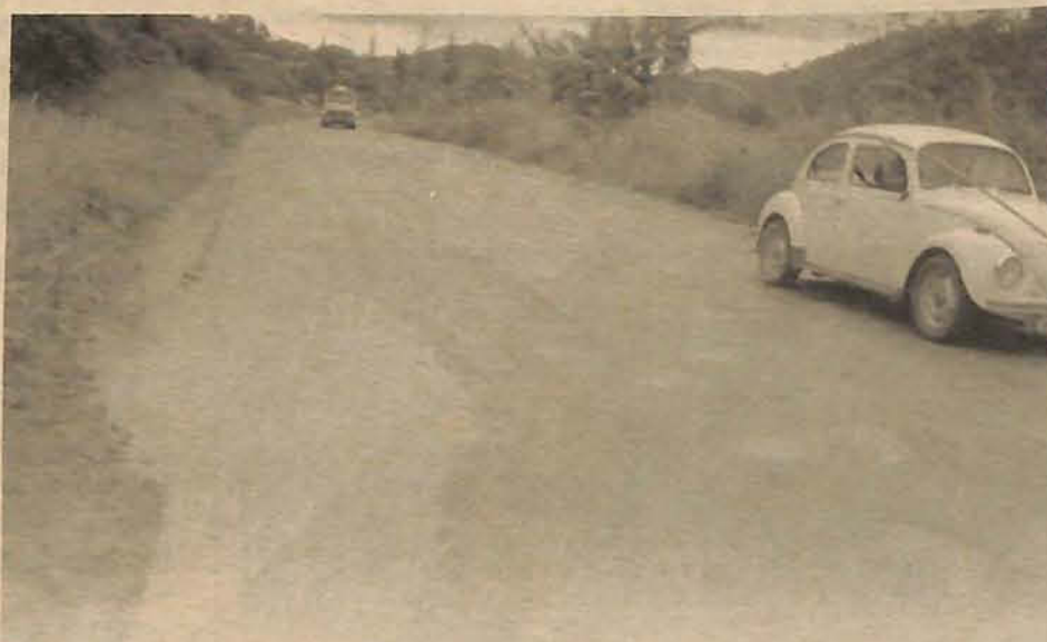
Recursos também serão usados na pavimentação e drenagem pluvial no Belchior
