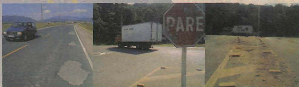
Buracos fazem fila na Ivo Silveira Trevo de acesso pela BR-470 é perigoso Lixo se acumula no meio da pista
